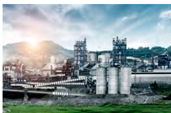
Stavební hmoty přeprava cementu potřebný tlak 4 bar
